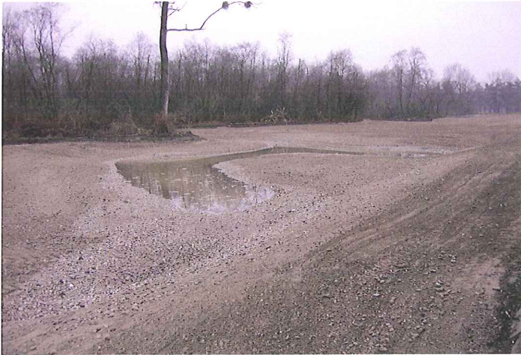
Oktober 2007 nach abschieben des nährstoffreichen Oberboden und Gestaltung der Fläche
